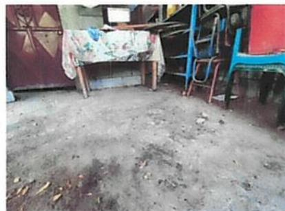
FOTO 6: PISO DETERIORADO Y FALTANTE EN UNAS ÁREAS
