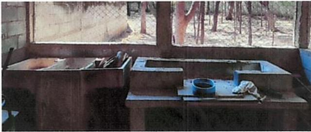
FOTO 3: ESTUFA SIN PLANCHA, SIN CHIMENEA Y PILA SIN SUMINISTRO DE AGUA
